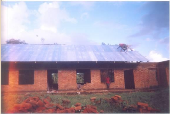
Dachdecker am Werk
